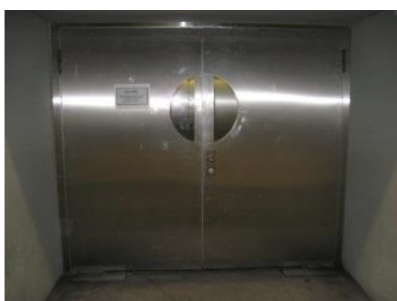
Eingang Haus A Foyer A1
