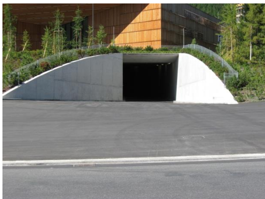
Einfahrt Tunnel zum Lieferanteneingang
